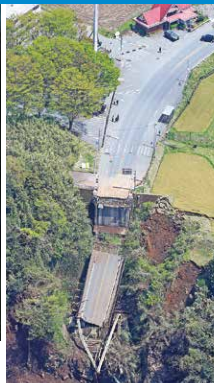
崩落した阿蘇大橋＝熊本県南阿蘇村で本社機から
