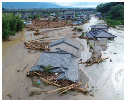
川があふれ、1階部分が埋まった民家＝福岡県朝倉市で7月7日、小型無人機で後藤由耶撮影
