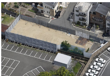
解体された京都アニメーション第1スタジオの跡地。=京都市伏見区で20年4月28日
