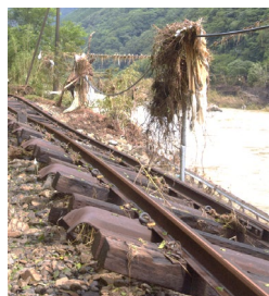
豪雨により傾いた線路=熊本県球磨村一勝地で2020年7月12日
