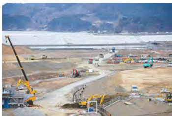
かさ上げ工事の様子—岩手県陸前高田市で2017年2月
